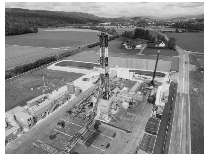
Chantier de Haute-Sorne en mai 2024
