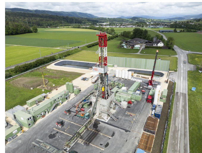
Chantier de Haute-Sorne en mai 2024
